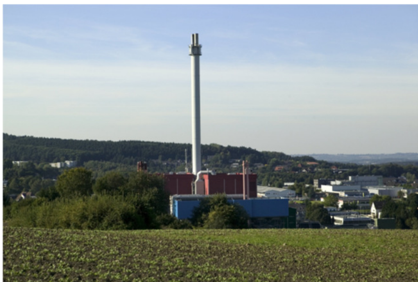
Abbildung 32: Rückseitige Ansicht des MHKW Iserlohn
