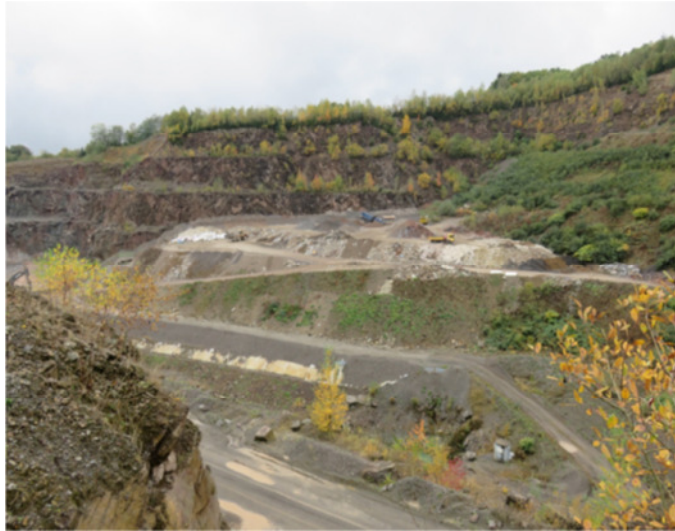
Abbildung 38: Verfüllstand im 4. Bauabschnitt
