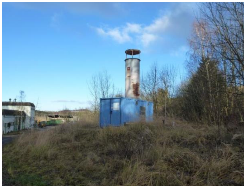
Abbildung 39: Gasstation mit Hochtemperaturfackel
