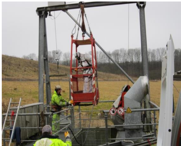
Abbildung 40: Kamerabefahrung Kontrollschacht 2
