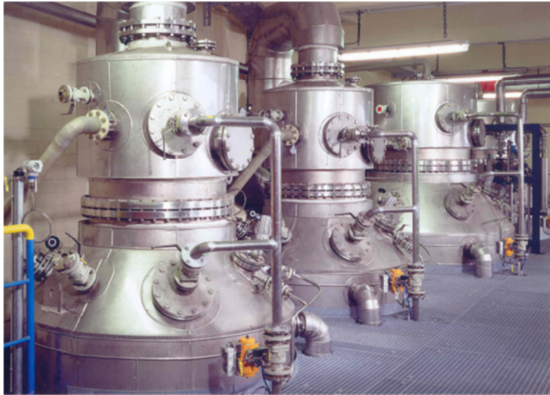
Abbildung 35: Eindampfanlage zur Einspeisung des Dampfes ins Fernwärmenetz
