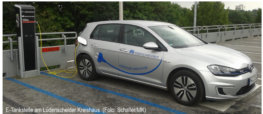
E-Tankstelle am Lüdenscheider Kreishaus (Foto: Schaller/MK)
