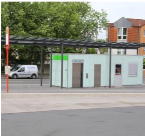
Behinderten-WC, Fahrbahnaufbau, Hochbord, rutschfester Bordstein
